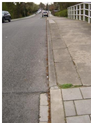
Figuur 9 opsluiting asfalt-band en kabelgoot
