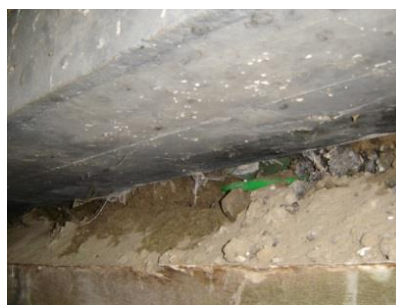
Figuur 3 Mantelbuis zichtbaar
