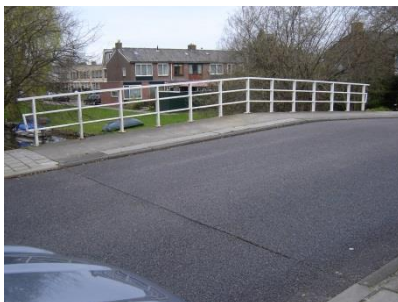
Figuur 1 overzicht brug 7
