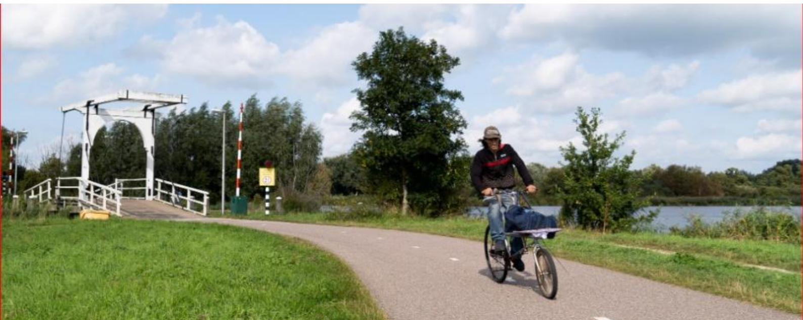
Afb. 2. Fietspad en Luijendijksluisbrug
