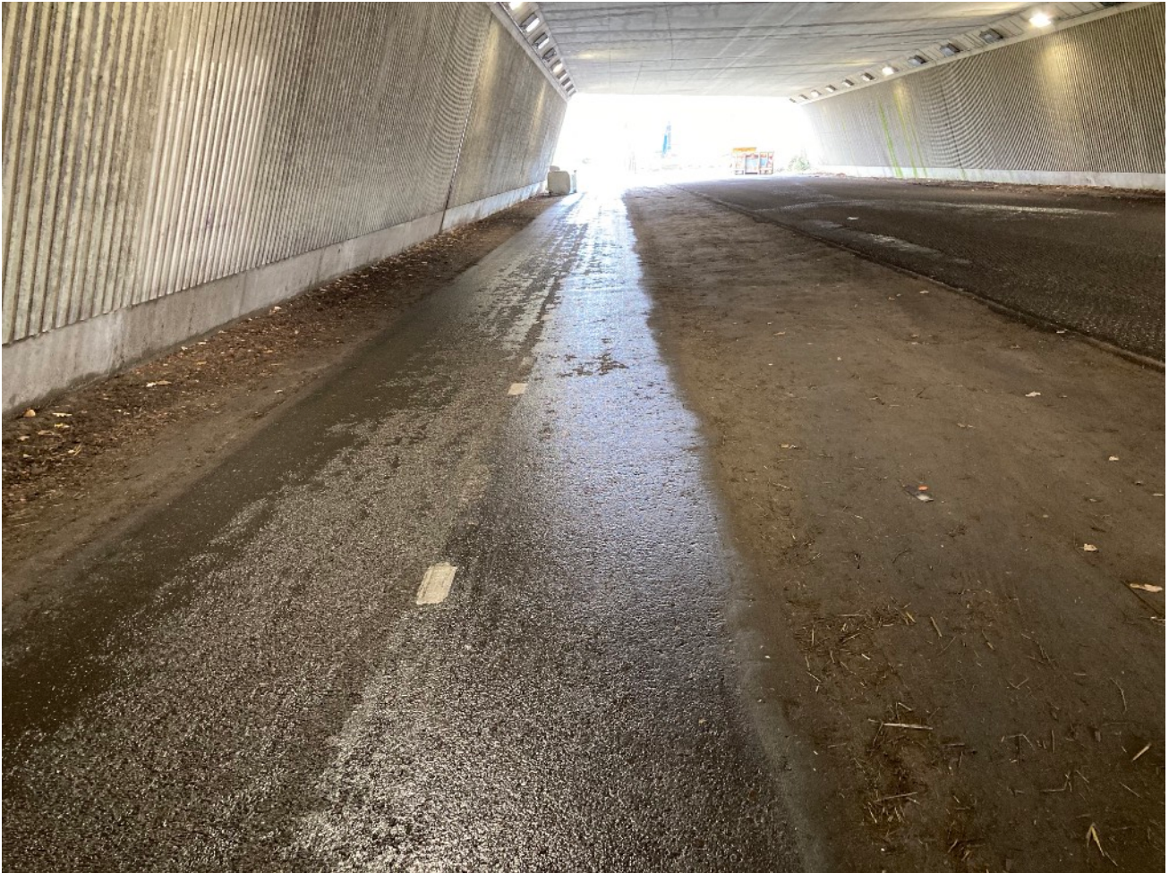
Fietspad Zuiderweg onder viaduct A7
